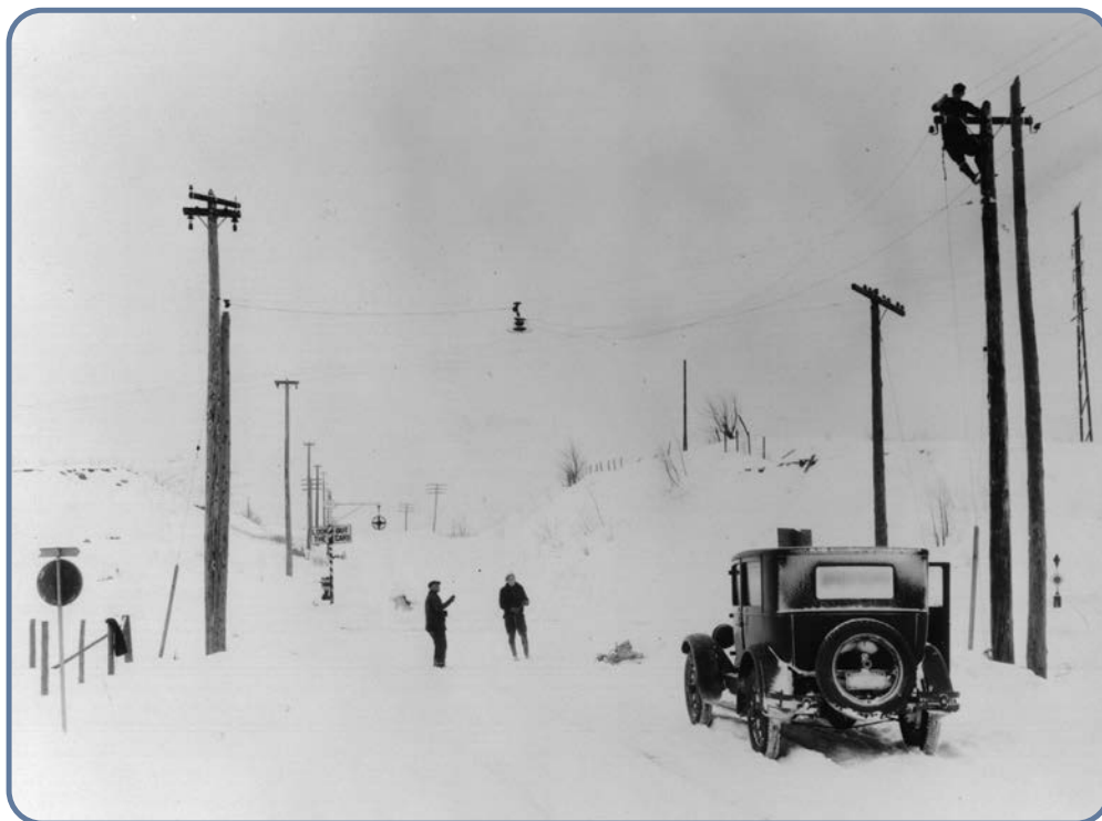
Installing electric wires, Fond du Lac, WI 1934
