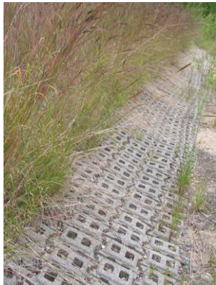
Armorflex® Revetment
